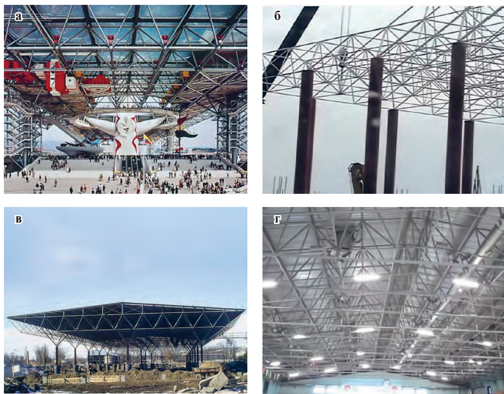
Рис. 3.5.12. Примеры пространственно-стержневых плит покрытия: а) покрытие сооружения выставки «ЭКСПО-70» в Японии; б) покрытие спорткомплекса в Витязево; в) здание в г. Пятигорск; г) покрытие над ледовой ареной в г. Пружаны (Белоруссия)
