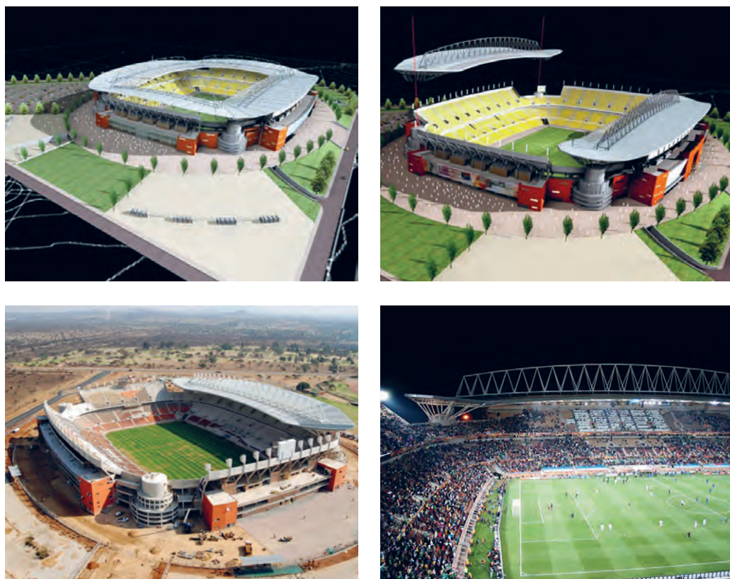
Рис. 3.2.8. Пример покрытия с фронтальной фермой («Peter Mokaba Stadium», ЮАР)
