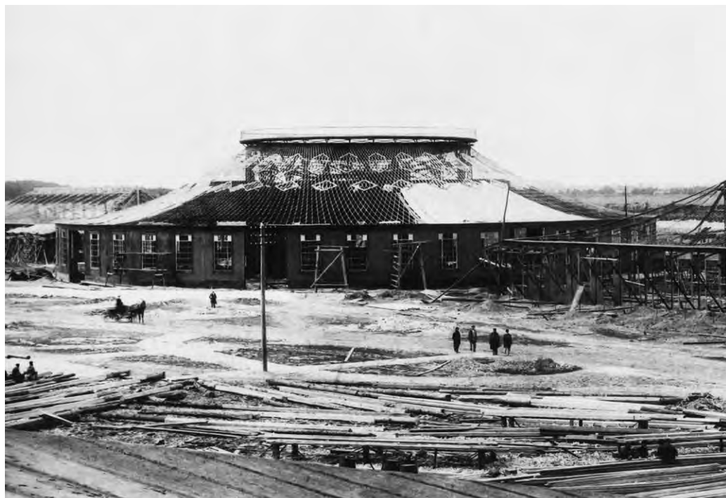
Рис. 3.6.1. Инженерно-строительный павильон круглой формы с висячим покрытием на Всероссийской художественной и промышленной выставке в Нижнем Новгороде, запроектированный В. Г. Шуховым
