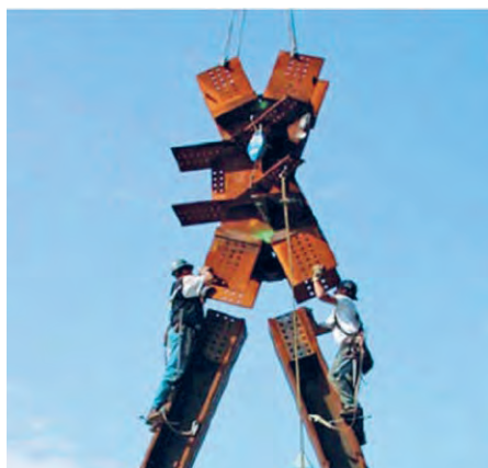
Рис. 2.5.4. а) узел ДСО башни Сент-Мэри Экс 30 [65]; б) узел ДСО башни Херст- тауэр
