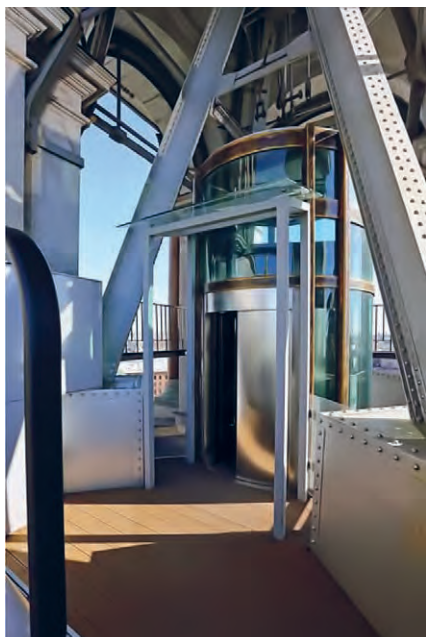
Рис. 2.7.7. Лифтовая шахта для подъема маломобильных групп населения в Исаакиевском соборе в Санкт-Петербурге
