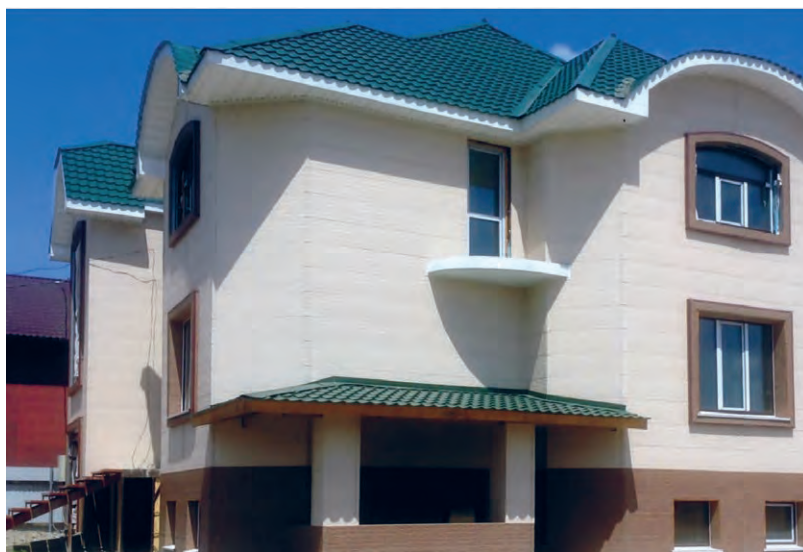
Рис. 1.2.5. Наружная стена из трехслойных металлических панелей
