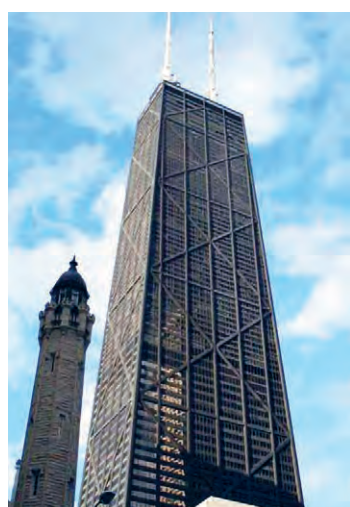
Рис. 1.4.10. Связевой каркас с внешним стволем жесткости
