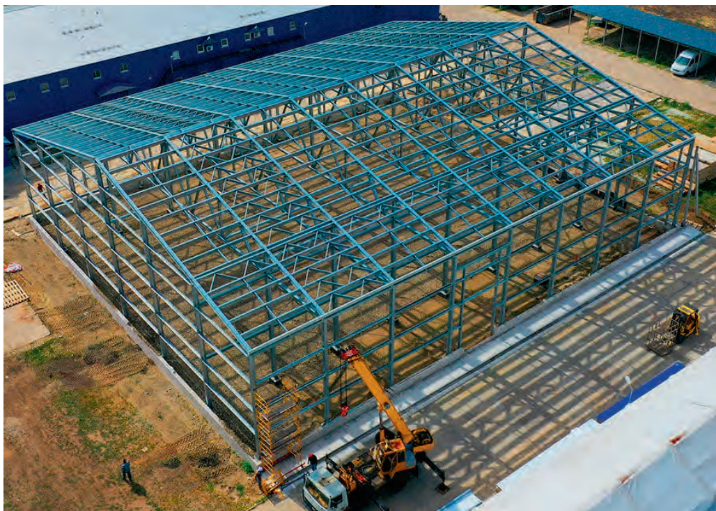
Рис. 9.5.1. Монтаж трехпролетного каркаса из ЛСТК. Объект — производственное здание 36 х 41 х 8(н) м. Московская область, 2018 г.
