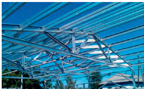
Рис. 10.1.1. Примеры применения прогонов из стальных оцинкованных профилей: а), б) - в каркасах с рамами из двутавров; в), г) — в каркасах из ЛСТК
