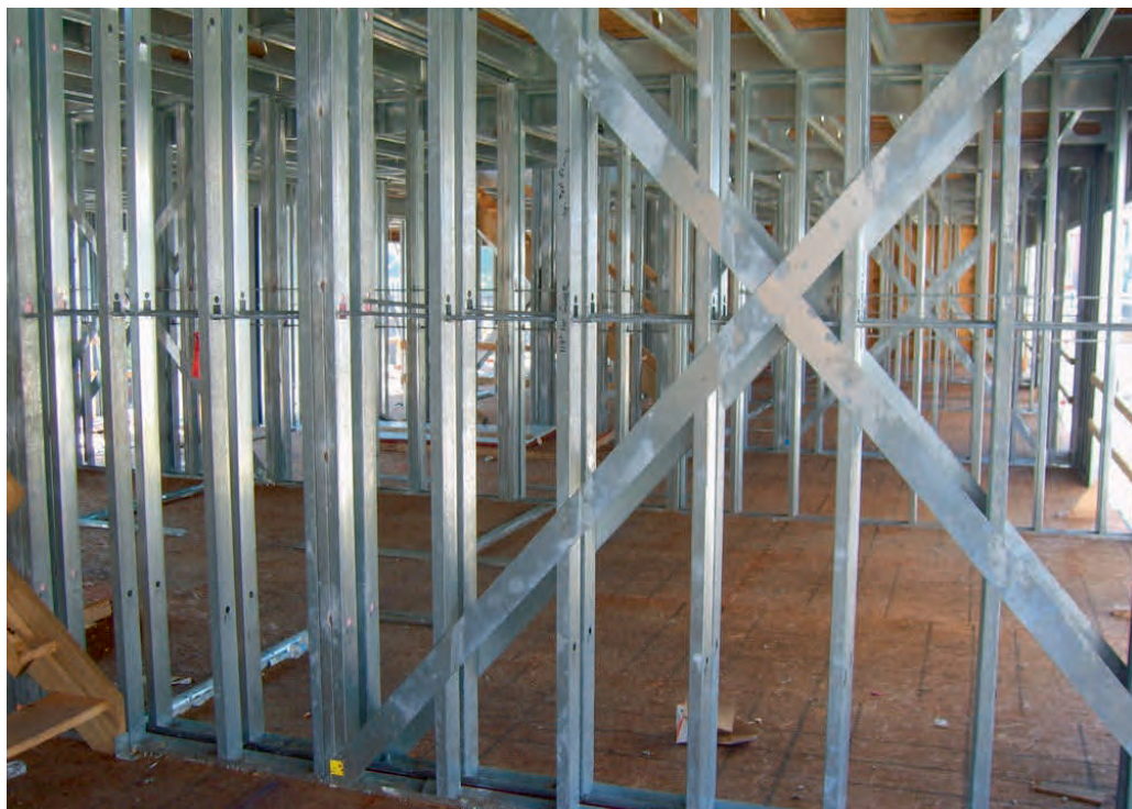
Рис. 11.2.5. Каркас внутренних стен и перегородок
