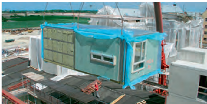
Рис. 11.1.17. Модули, опирающиеся на несущий каркас здания
