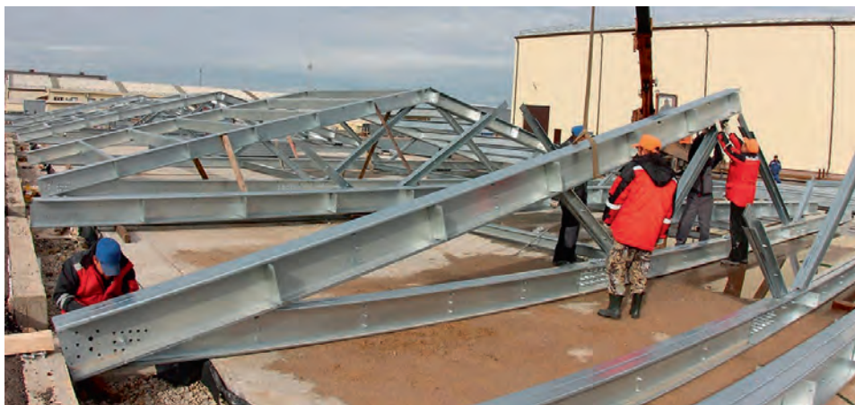
Рис. 9.5.20. Укрупнительная сборка ферм на строительной площадке. Объект: производственное здание 18 x 84 x 12 (h) м.
