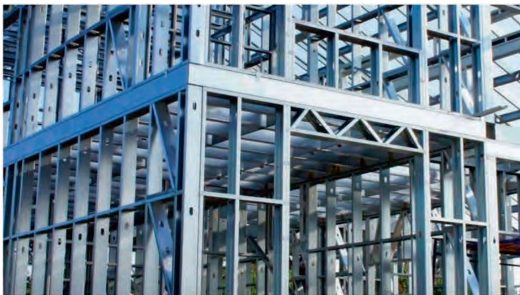
Рис. 11.2.2. Каркас панелей стен из гнутых профилей сплошного сечения
