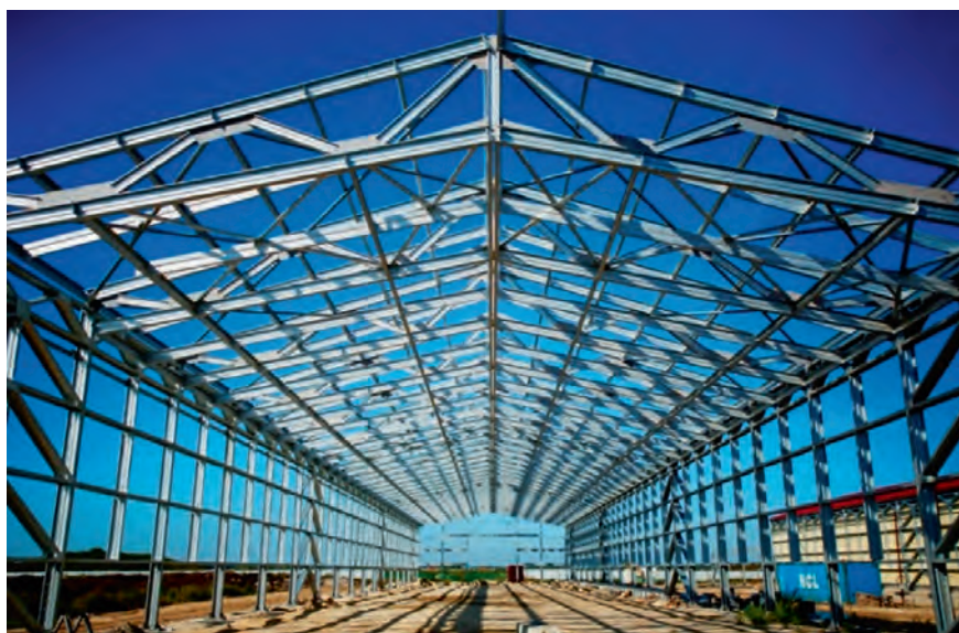
Рис. 1.2.14. Рамный каркас с решетчатым ригелем переменного сечения
