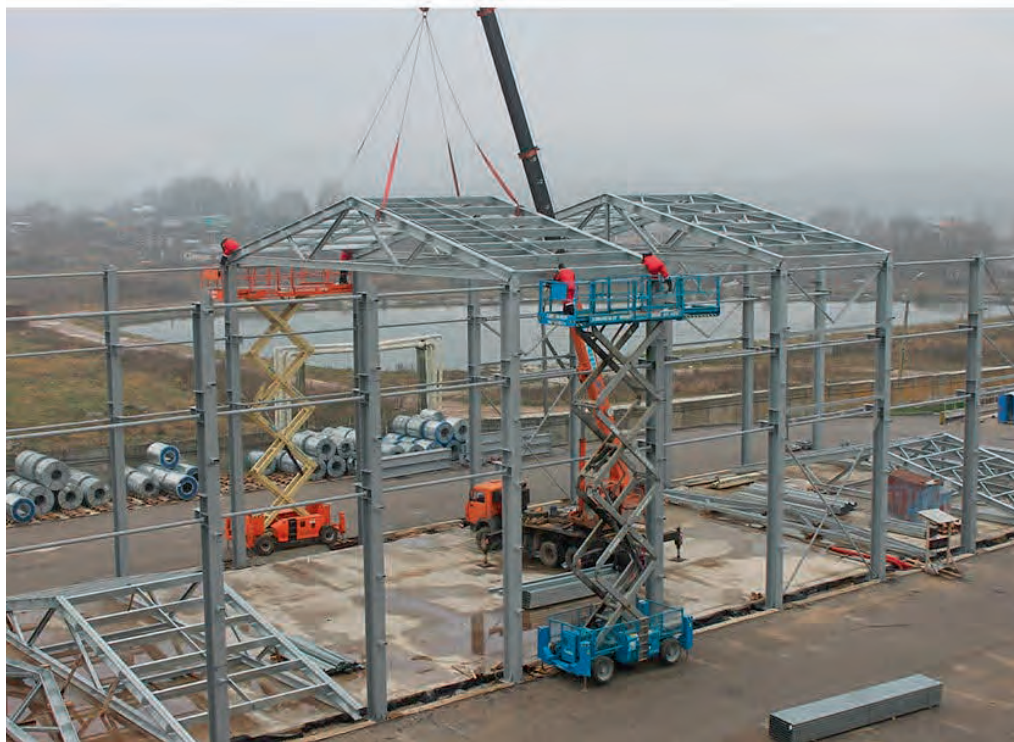
Рис. 9.5.28. Установка укрупненных блоков из пар ферм пролетом 18 м. Объект — производственное здание, Калужская область, 2018
