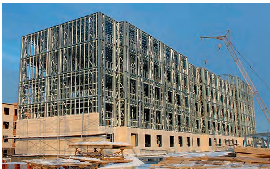
Рис. 9.5.13. Монтаж ЛСТК-каркаса 6-этажного трехсекционного жилого дома, Калужская область, 2014.
