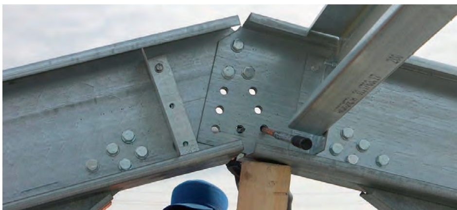
Рис. 9.5.2. Использование монтажных пробок для совмещения отверстий деталей в коньковом узле фермы из ЛСТК
