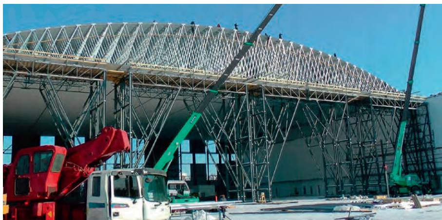
Рис. 1.2.24. Общий вид возведения большепролетного бескаркасного здания
