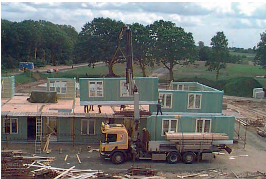
Рис. 11.1.8. Монтаж панелей стен с обшивкой и утепляющими материалами
