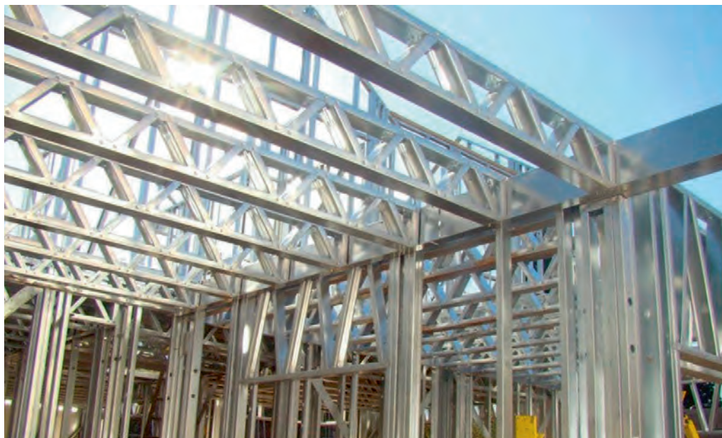
Рис. 11.2.10. Несущие конструкции перекрытия из ферм
