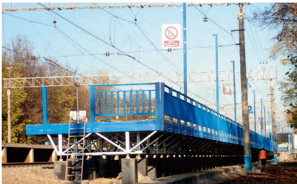
Рис. 1.2.27. Железнодорожная платформа с несущими конструкциями из ЛСТК
