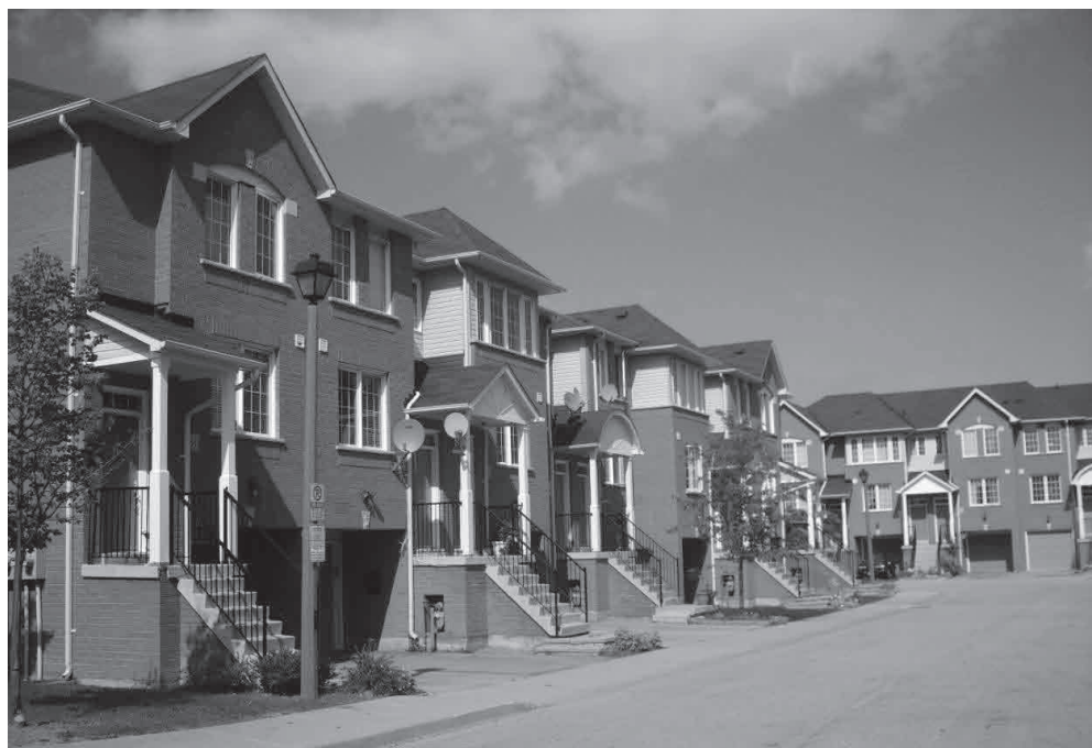
Рис. 11.6.6. Финишная облицовка стен здания облицовочным кирпичем
