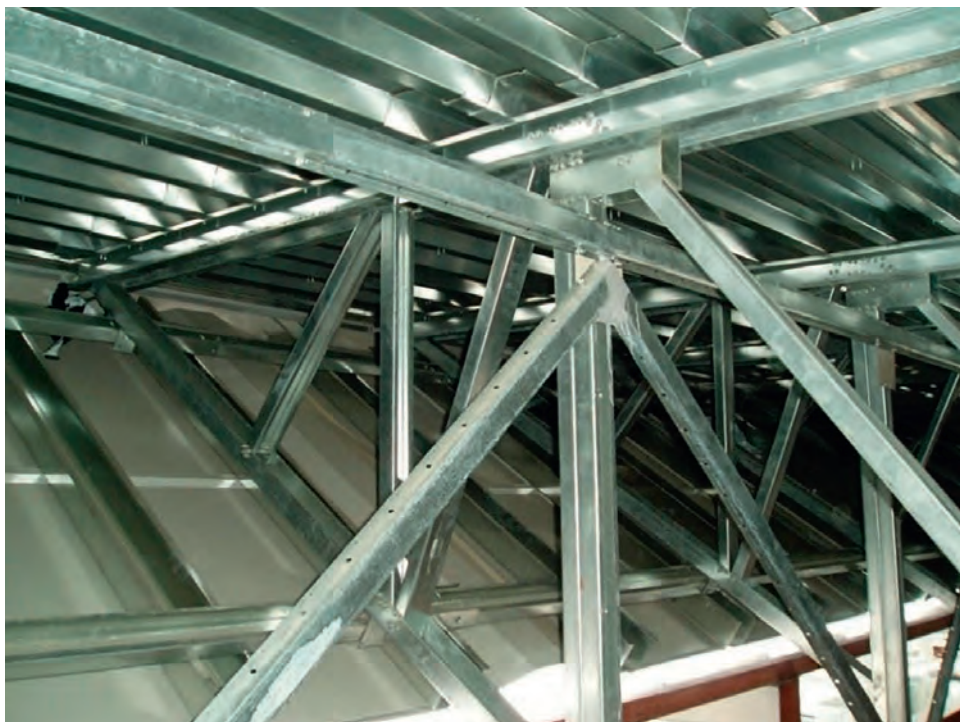
Рис. 1.2.7. Использование ЛСТК для подконструкций, поддерживающих кровлю
