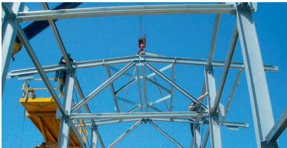
Рис. 9.5.27. Установка центрального кровельного пролета трехпролетного здания. Объект: склад-холодильник 36 x 90 x 7,6 (h) м, Краснодарский край, 2016
