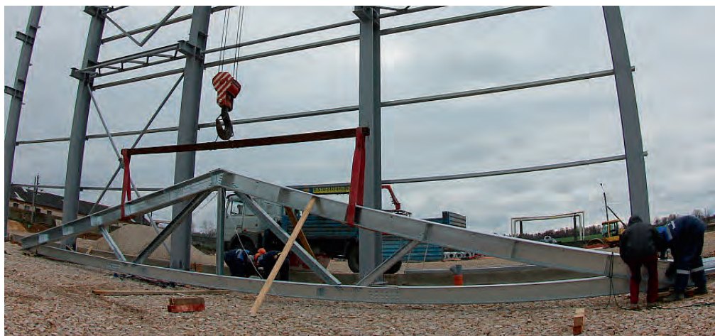
Рис. 9.5.24. Подъем одиночной фермы с помощью траверсы. Объект – производственное здание, Калужская область, 2017
