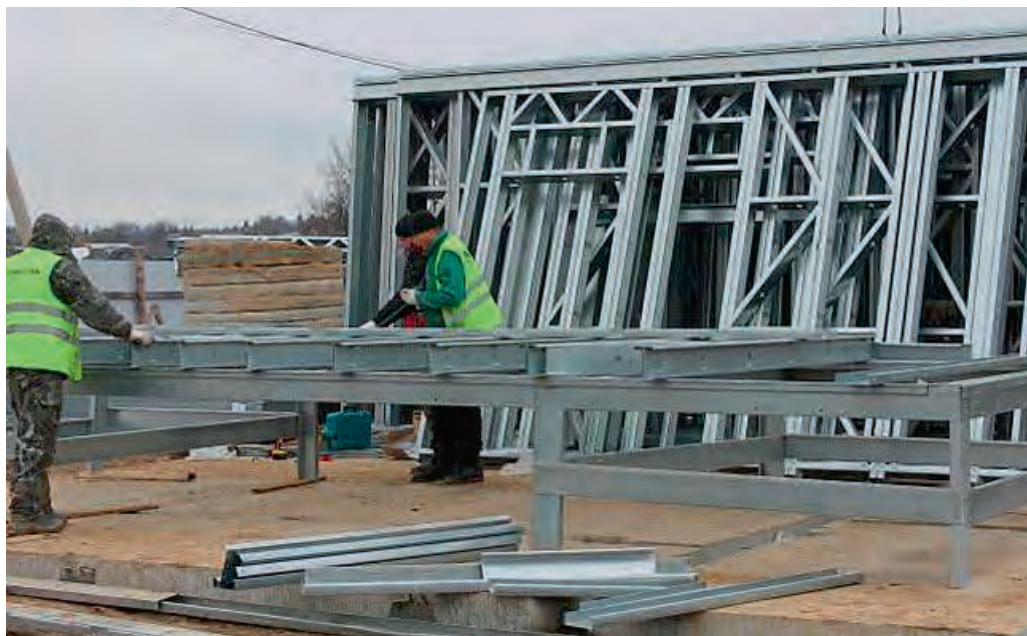
Рис. 9.5.8. Сборка панелей на строительной площадке. Объект: 6-этажный жилой дом с каркасом из ЛСТК, Калужская область, 2013.
