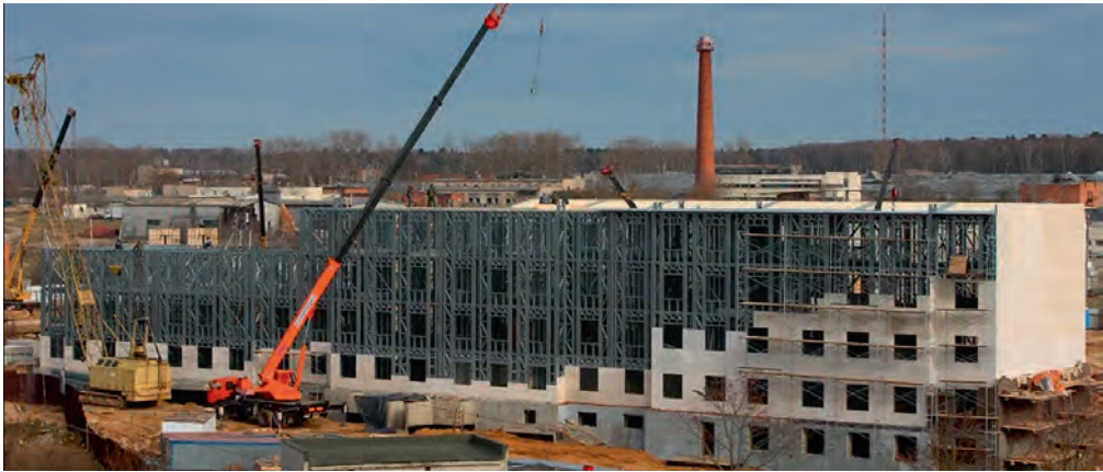
Рис. 9.5.3. Монтаж ЛСТК дома с разбежкой в 1 этаж. Объект: 4-этажный жилой дом, Калужская область, 2013.
