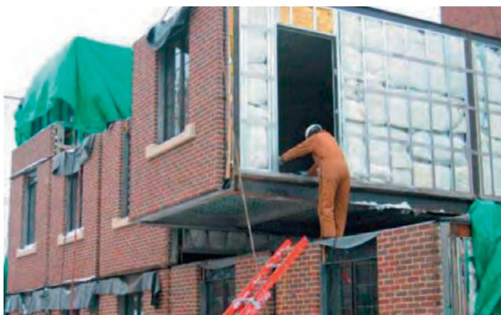
Рис. 11.1.16. Модули с непрерывной опорой несущего каркаса
