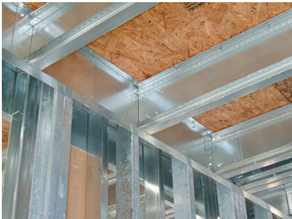
Рис. 11.2.12. Настил перекрытия из OSB
