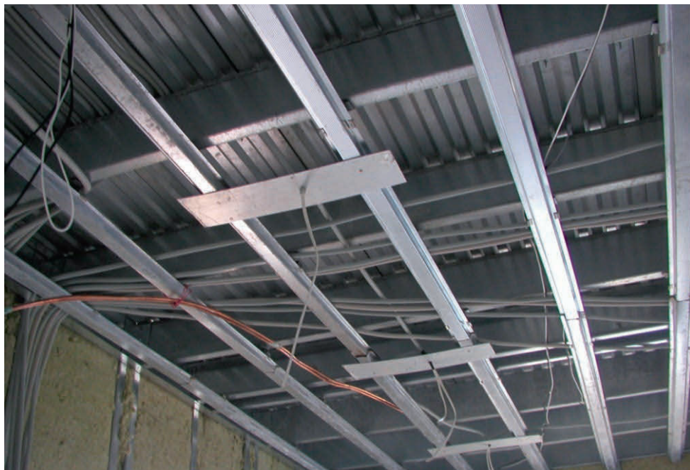
Рис. 11.2.14. Размещение скрытой проводки в междуэтажном перекрытии
