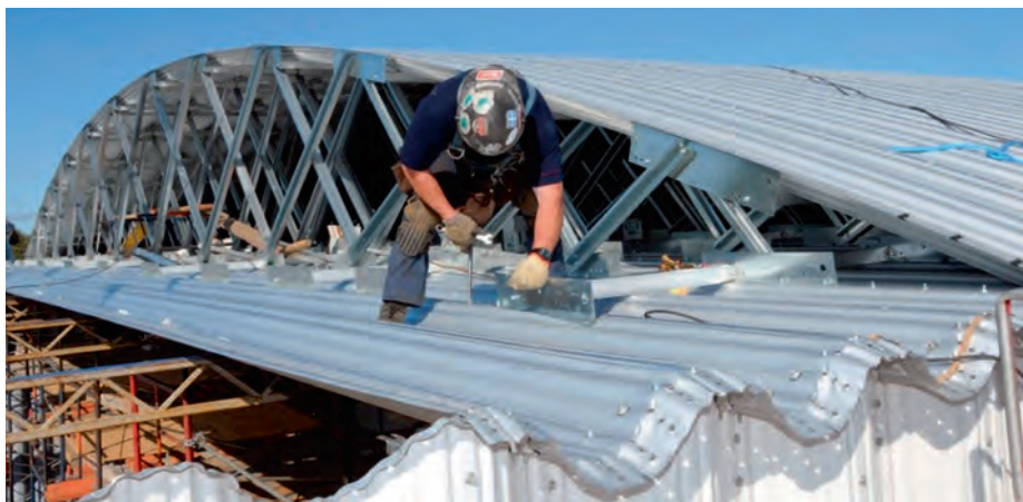
Рис. 1.2.23. Монтаж элементов бескаркасного здания
