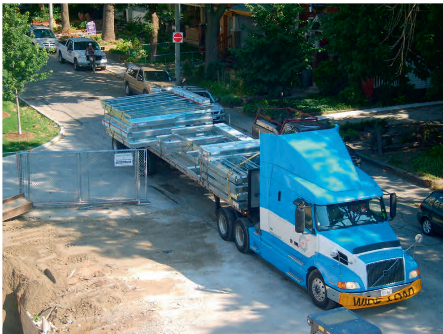
Рис. 11.1.6. Несущие панели стен без обшивки и внутренних слоев
