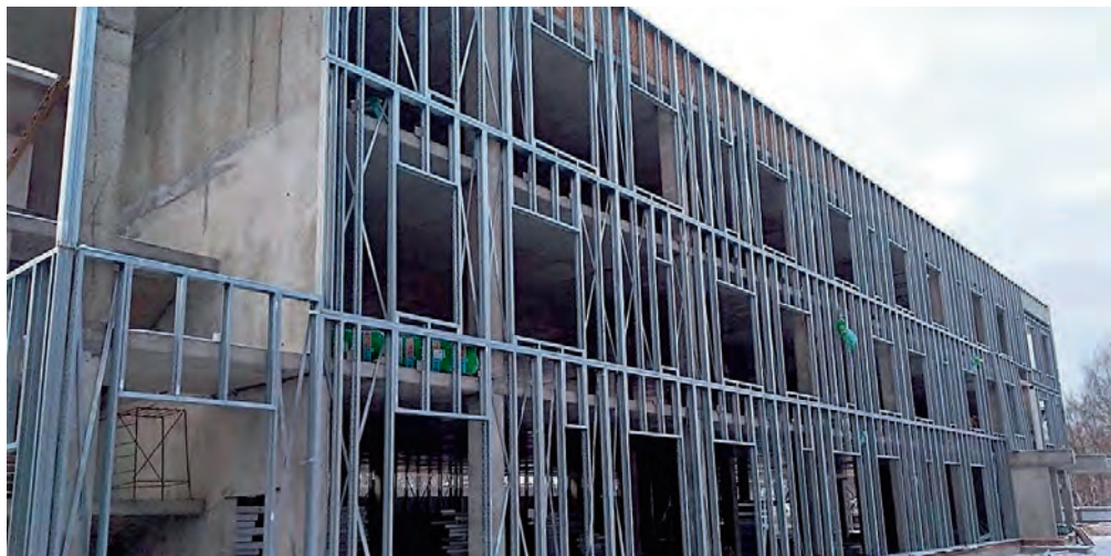
Рис. 1.2.9. Каркас из ЛСТК каркасно-обшивной стены
