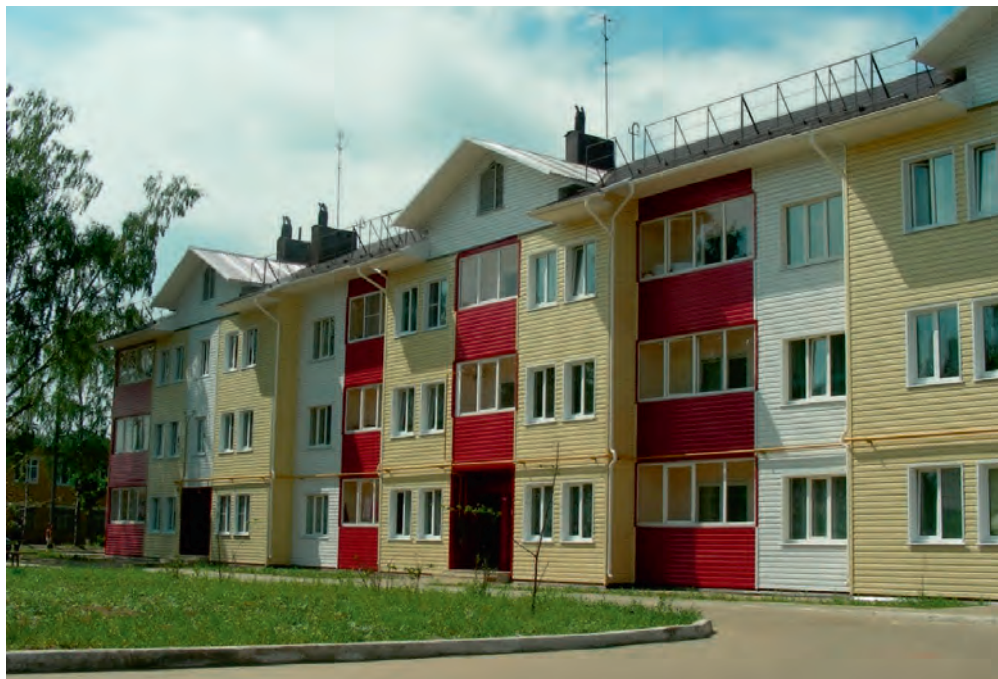
Рис. 11.6.3. Финишная облицовка стен здания сайдингом
