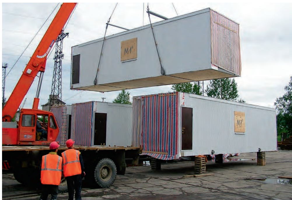
Рис. 1.2.19. Транспортируемый сборный строительный блок из ЛСТК
