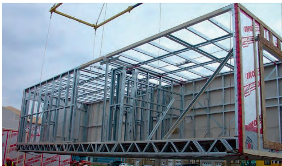
Рис. 11.1.13. ЛСТК открытого модульного блока
