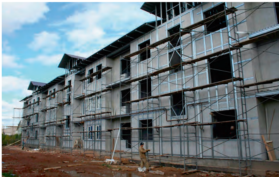
Рис. 11.6.2. Наружная обшивка стен здания
