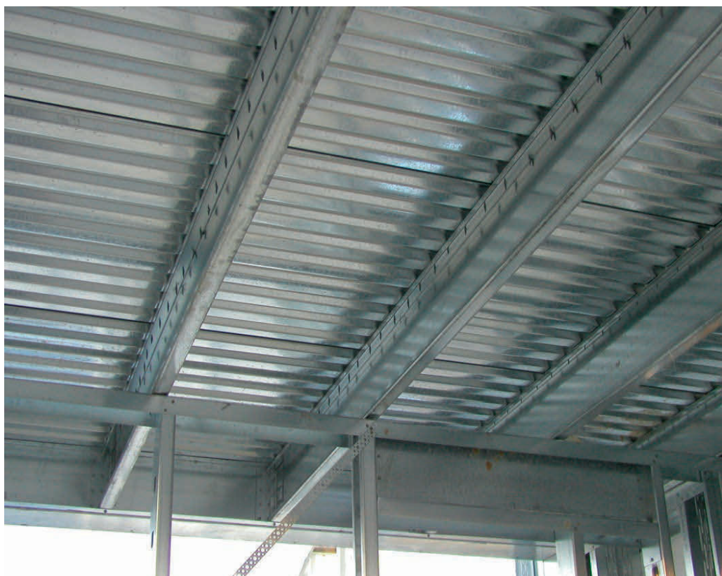
Рис. 11.2.11. Настил перекрытия из профилированных листов
