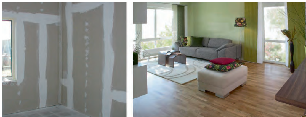
Рис. 11.6.1. Внутренняя обшивка стен гипсоволокнистыми листами и последующая финишная отделка стен
