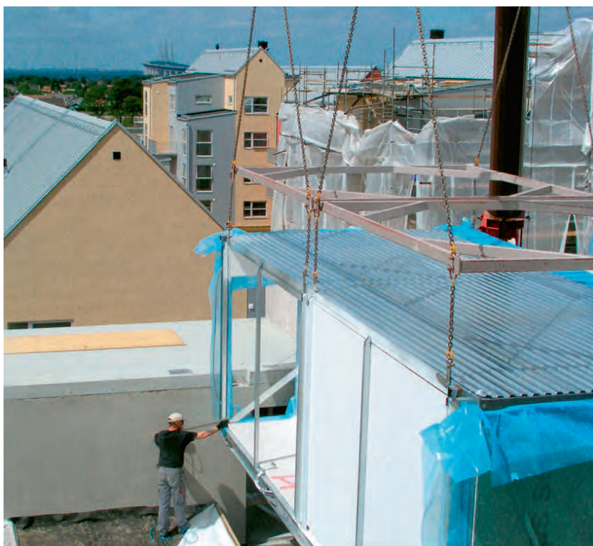
Рис. 11.1.22. Подъем модуля на место установки
