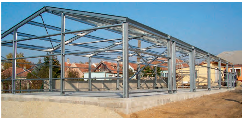
Рис. 1.2.2. Прогоны кровли и ригели стен стального каркаса из ЛСТК
