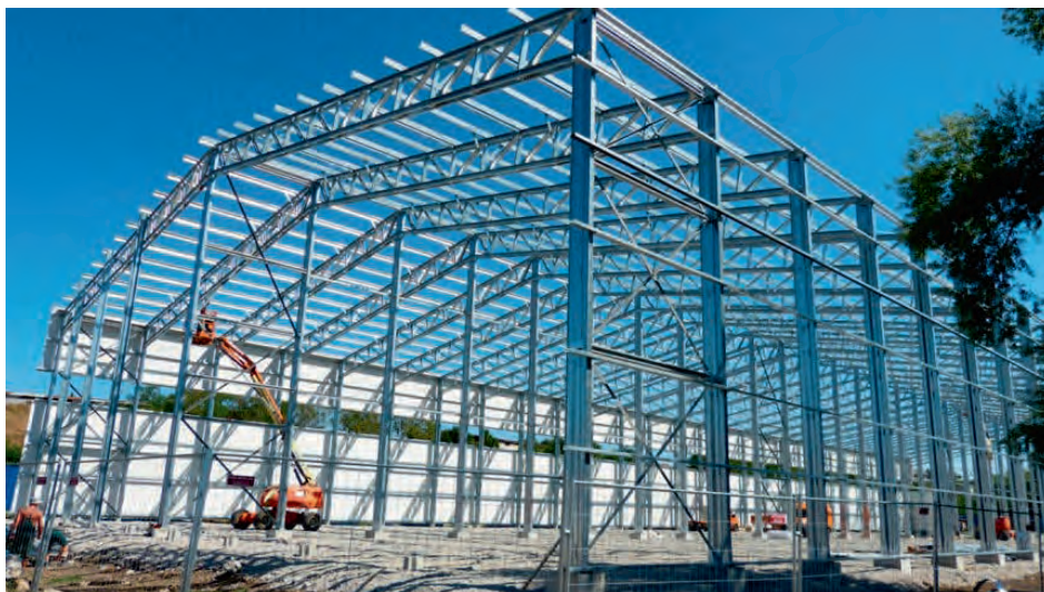
Рис. 1.2.13. Рамный каркас с решетчатым ригелем постоянного сечения
