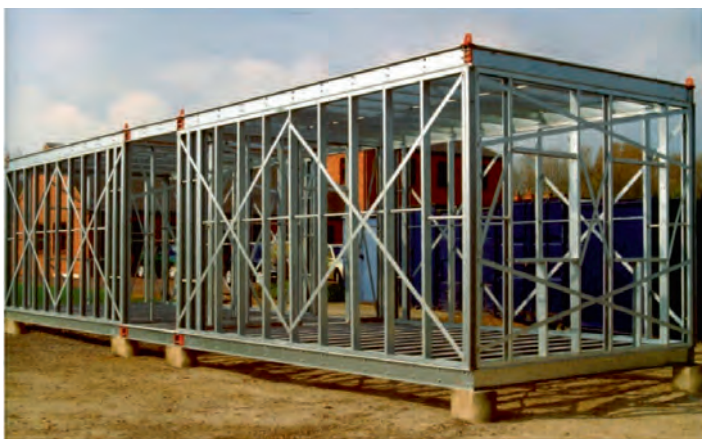
Рис. 11.1.15. Модули с угловой опорой несущего каркаса
