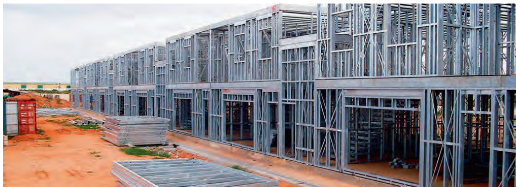
Рис. 11.2.1. Каркас стен здания из ЛСТК
