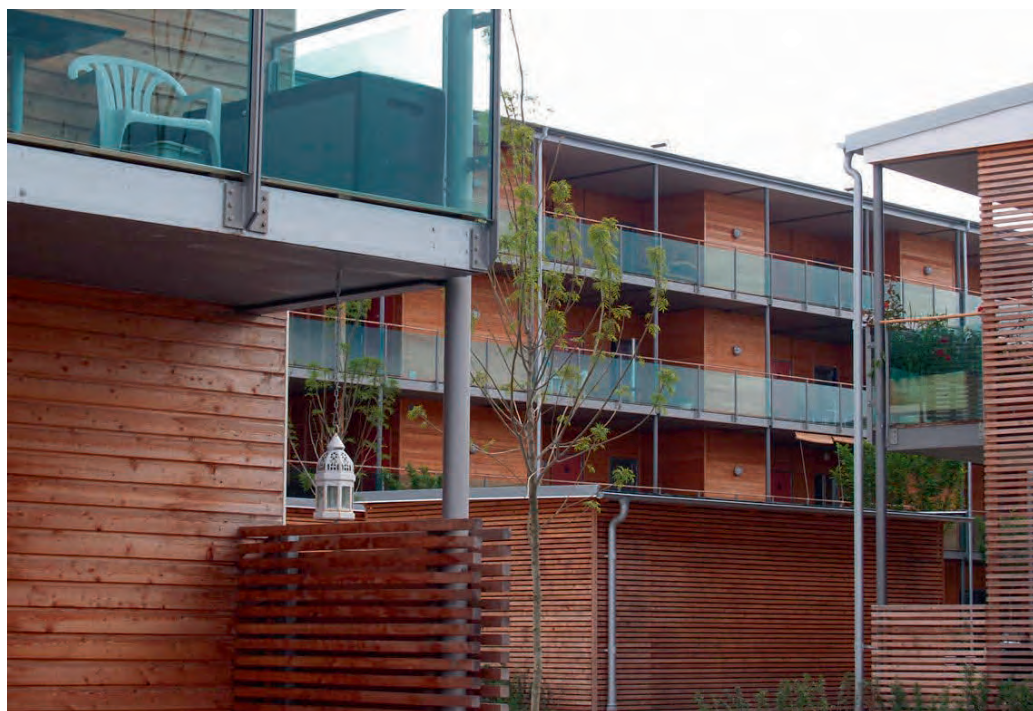
Рис. 11.6.7. Финишная облицовка стен здания досками и брусом из древесины
