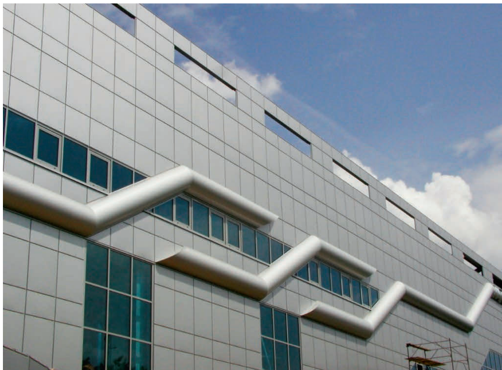
Рис. 1.2.4. Фасадные кассеты из тонколистового металла
