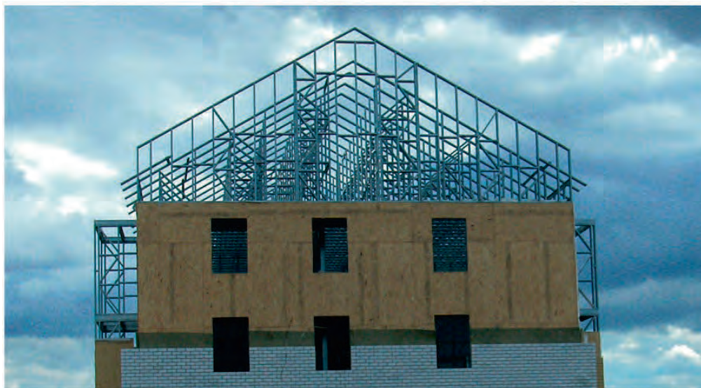
Рис. 9.5.14. Несущие конструкции скатной кровли. Объект: 3-этажный жилой дом
