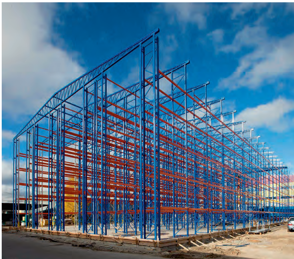
Рис. 1.2.25. Общий вид возведения самонесущего стеллажа склада
