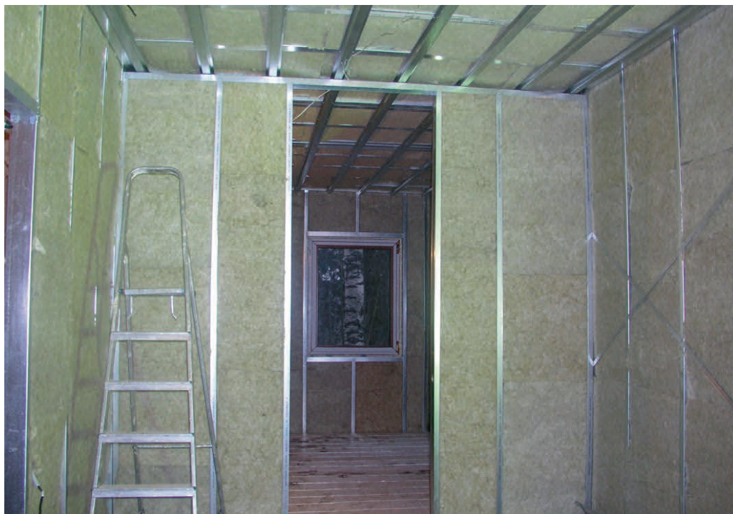
Рис. 11.2.6. Заполнение каркаса внутренних стен и перегородок минеральной ватой
