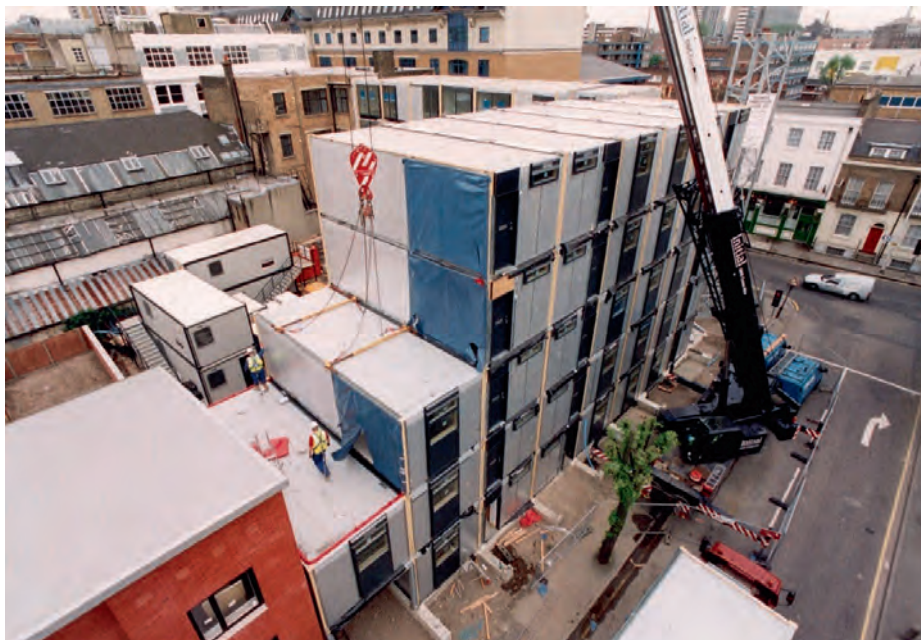
Рис. 11.1.23. Возведение многоэтажного здания из блоков в городском районе
