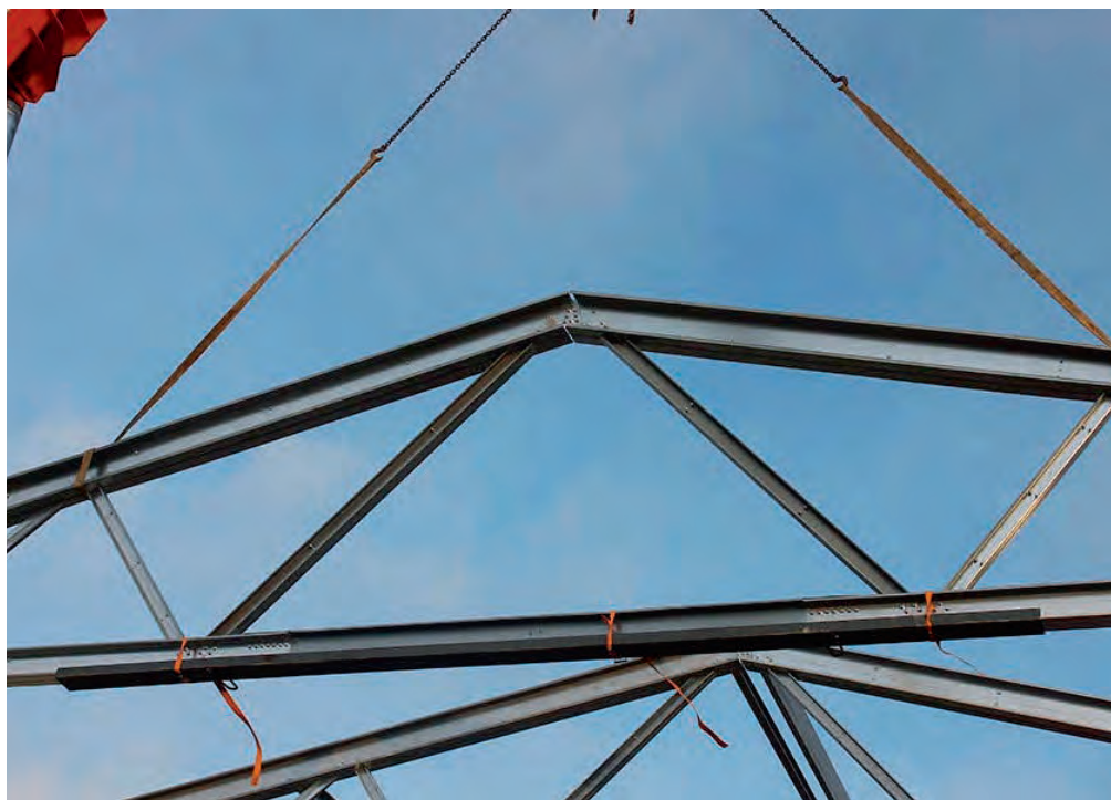
Рис. 9.5.25. Подъем одиночной фермы с использованием жесткой направляющей
