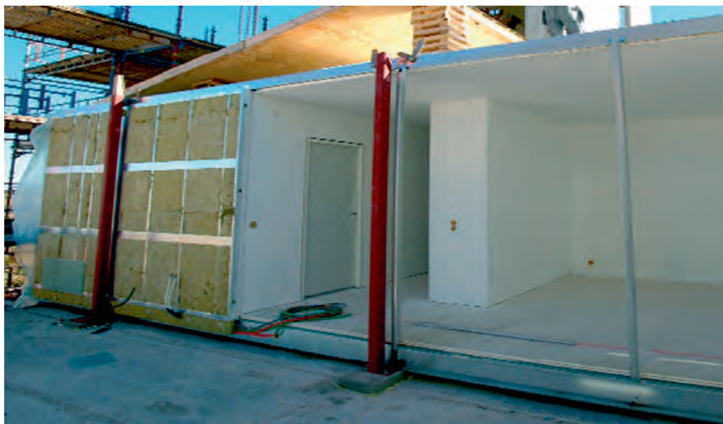
Рис. 11.1.14. Блок с открытой плоскостью стен для объединения в большой комнате
