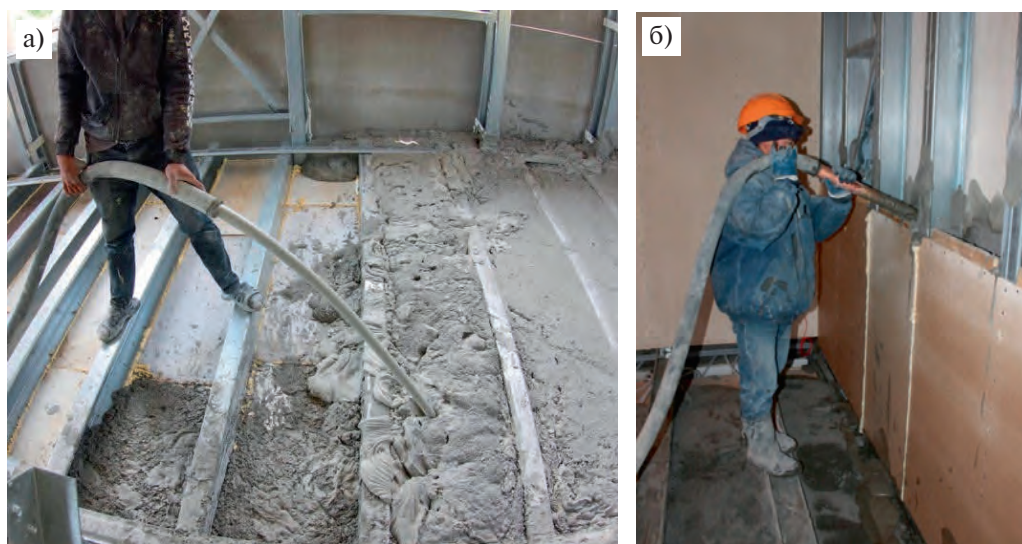
Рис. 12.3.1. Процесс заливки пенобетона: а) перекрытие; б) стена (объект: 6-этажный жилой дом, Калужская область, 2013.
