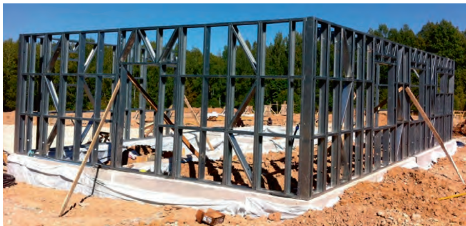
Рис. 9.5.9. Монтаж первого фрагмента 2-этажного офисного здания из ЛСТК, Калужская область, 2015.
