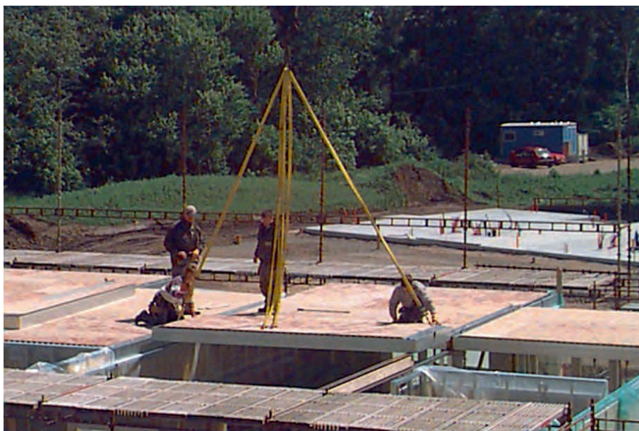
Рис. 11.1.9. Монтаж панелей перекрытий
