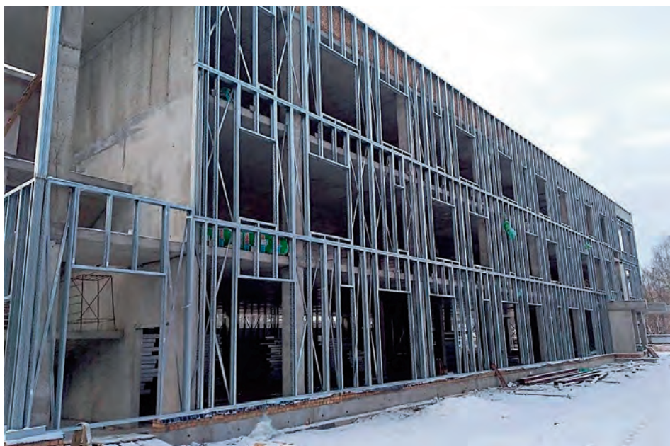
Рис. 12.1.1. Общий вид каркаса под обшивку стенового ограждения
