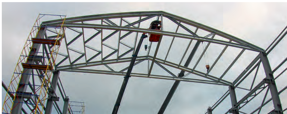
Рис. 9.5.26. Монтаж связевого блока. Объект — производственное здание, Калужская область, 2017
