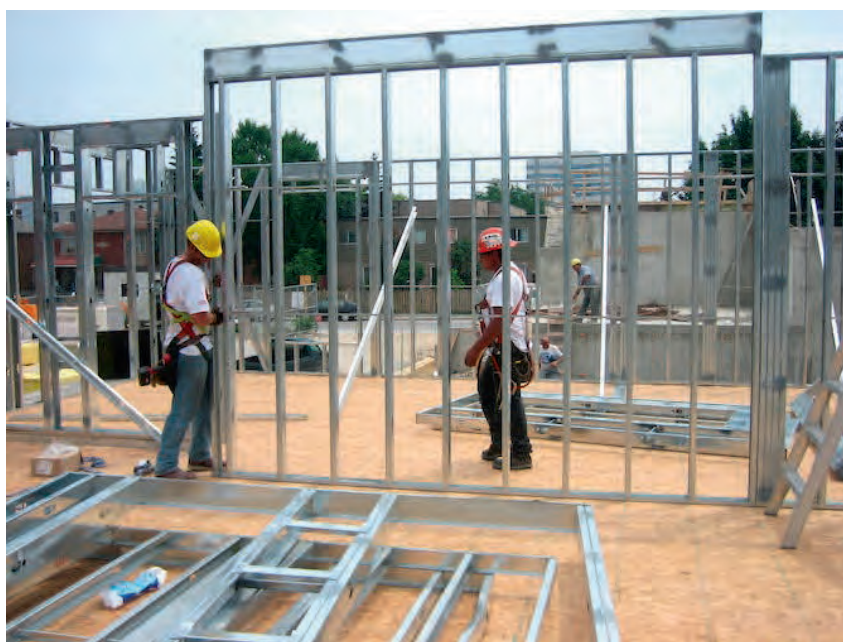
Рис. 11.1.3. Сборка несущего стального каркаса здания на строительной площадке
