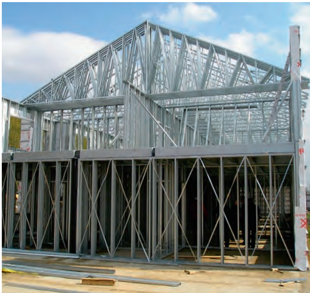
Рис. 1.2.15. Каркас жилого дома из ЛСТК
