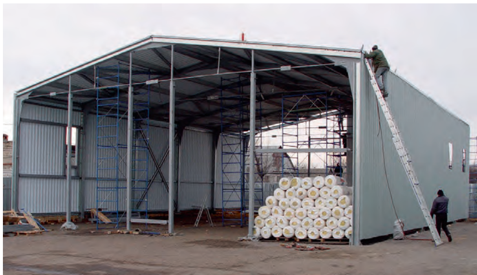
Рис. 1.2.12. Рамный каркас из парных гнутых профилей С-образного сечения
