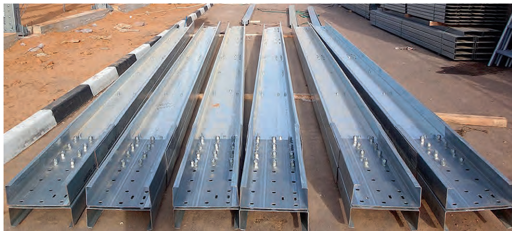
Рис. 9.5.18. Укрупнительная сборка колонн
