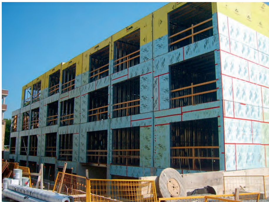
Рис. 11.3.2. Дополнительная наружная теплоизоляция здания
