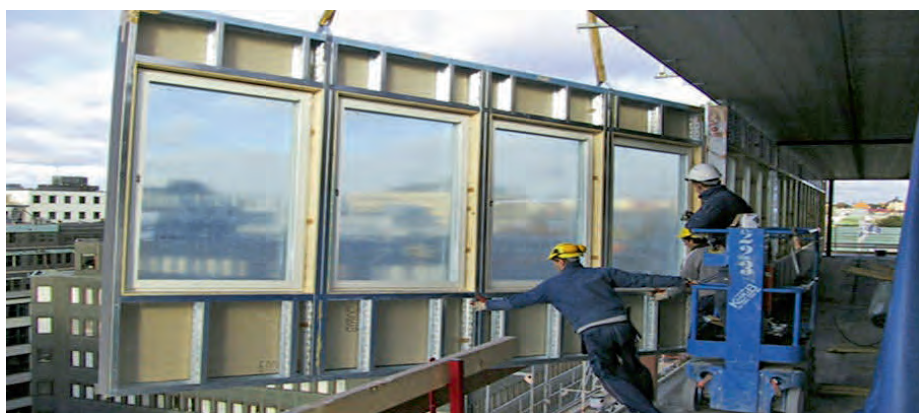
Рис. 11.1.7. Монтаж панели стен с односторонней обшивкой
