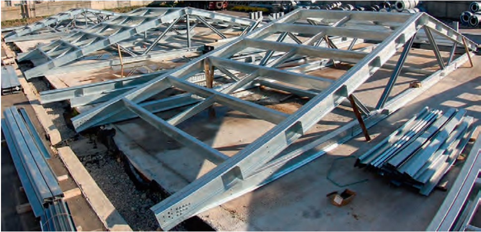
Рис. 9.5.21. Собранные кровельные пролеты перед установкой в каркас. Объект: производственное здание 18 x 84 x 12 (h) м
