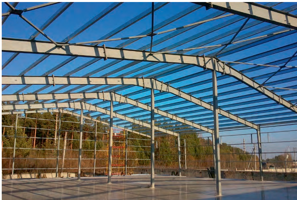
Рис. 1.2.1. Прогоны кровли и ригели стен промышленного здания
