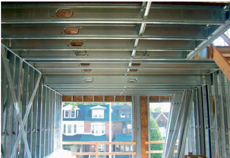
Рис. 11.2.9. Несущие балки перекрытия
