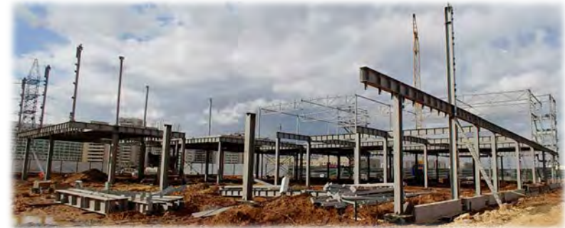
Монтаж каркаса здания
