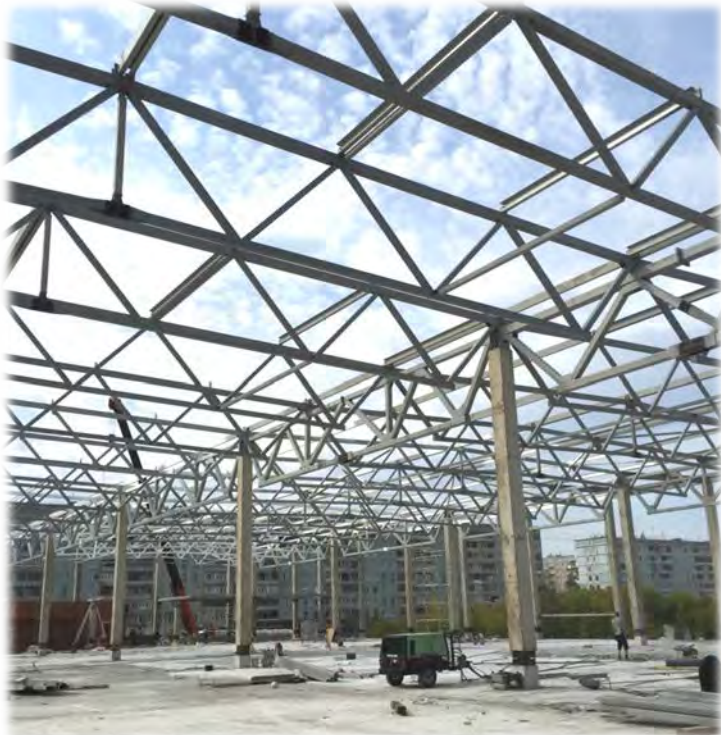
Монтаж каркаса здания
