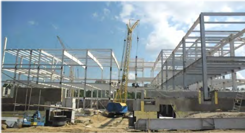
Монтаж конструкций каркаса
