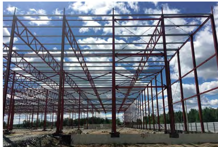
Монтаж каркаса здания
