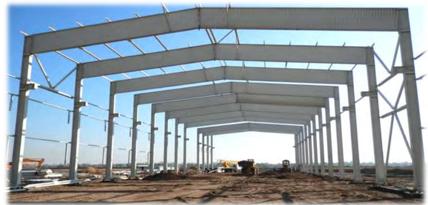
Монтаж каркаса производственного блока
