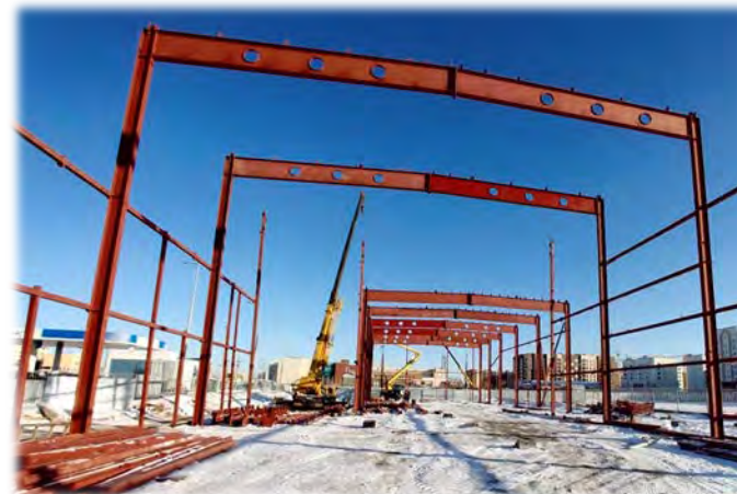
Монтаж каркаса здания
