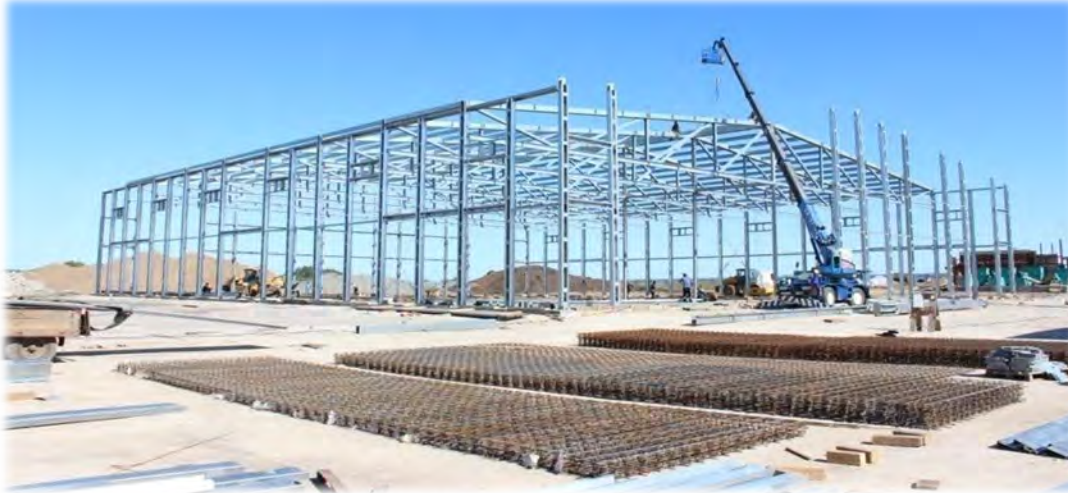
Монтаж каркаса здания
