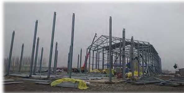
Монтаж каркаса здания
