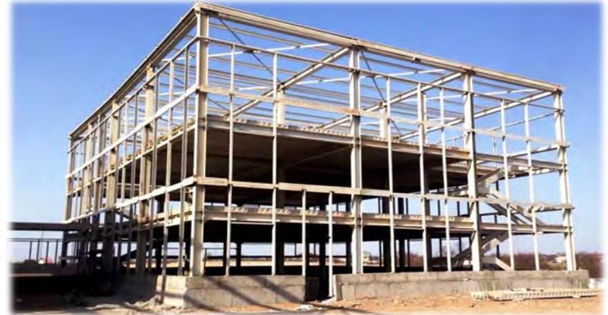
Монтаж каркаса офисного здания
