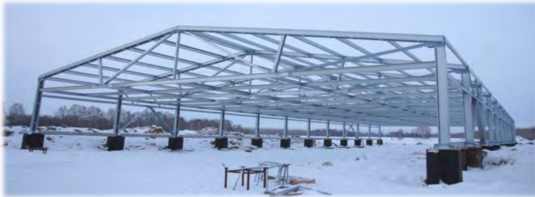
Монтаж каркаса Свинокомплекса
