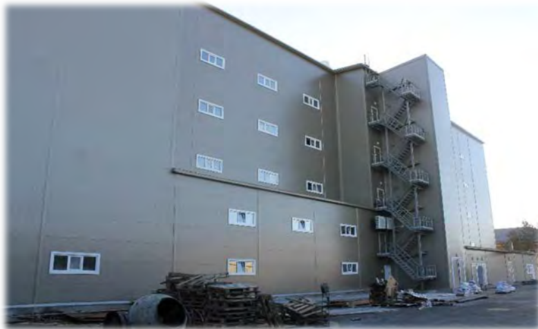
Общий вид здания мельницы
