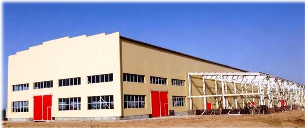
Монтаж стеновых панелей
