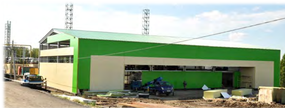
Монтаж стеновых панелей
