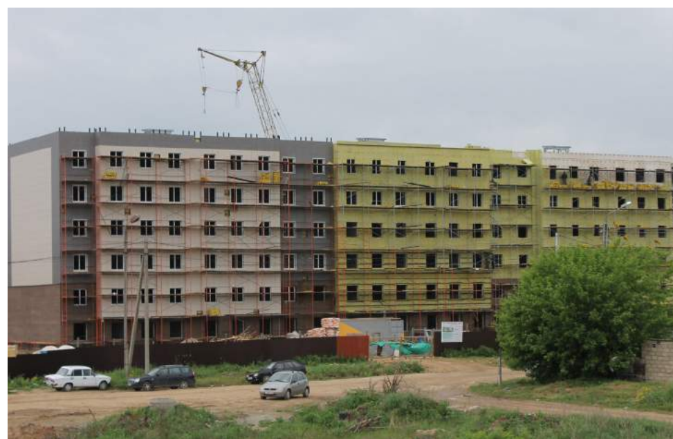
теплоизоляция здания: внутренняя – пенобетон, наружная - минвата
