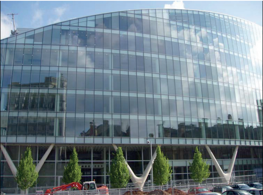
Рисунок 26 Фасадная стена с тройными стеклопакетами
