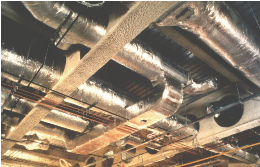
Рисунок 4 Конструкции перекрытия, покрытые огнезащитным составом
