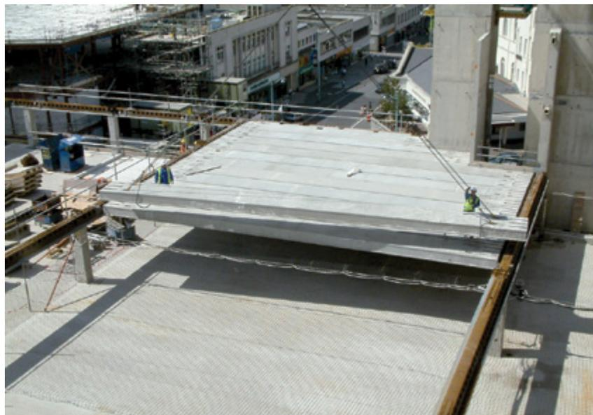
Рисунок 14. Укладка большепролетных пустотных плит.
