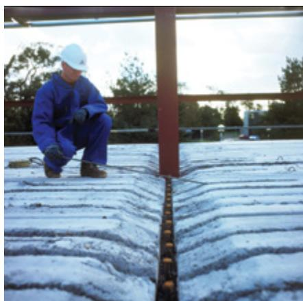
Рисунок 12. Усеченные края сборных плит и анкерные упоры, приваренные к стальной балке.
