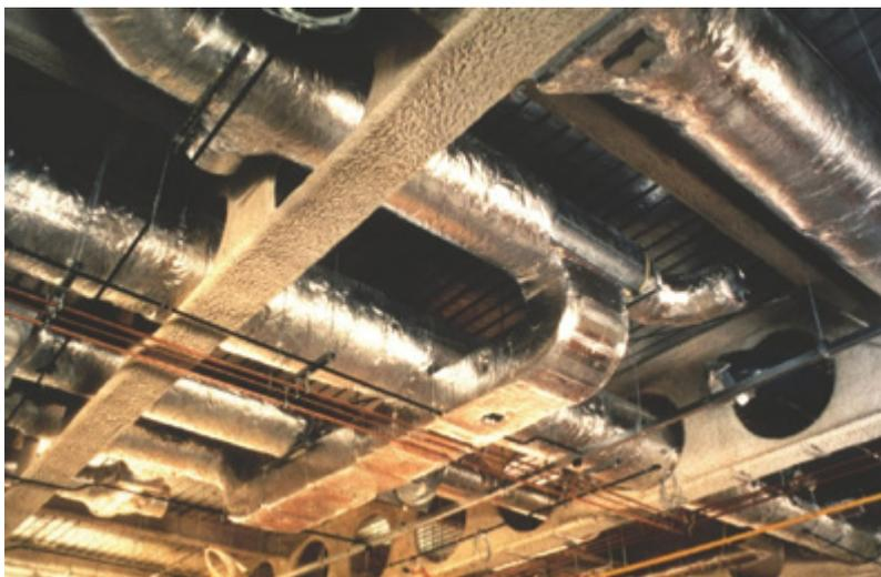
Рисунок 3. Конструкции перекрытия, покрытые огнезащитным составом.
