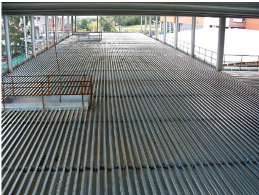
Рисунок 1. Уложенный профилированный настил создает удобную площадку для выполнения монтажных работ.
