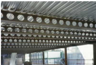
Рисунок 10. Сталежелезобетонные балки с перфорированной стенкой.
