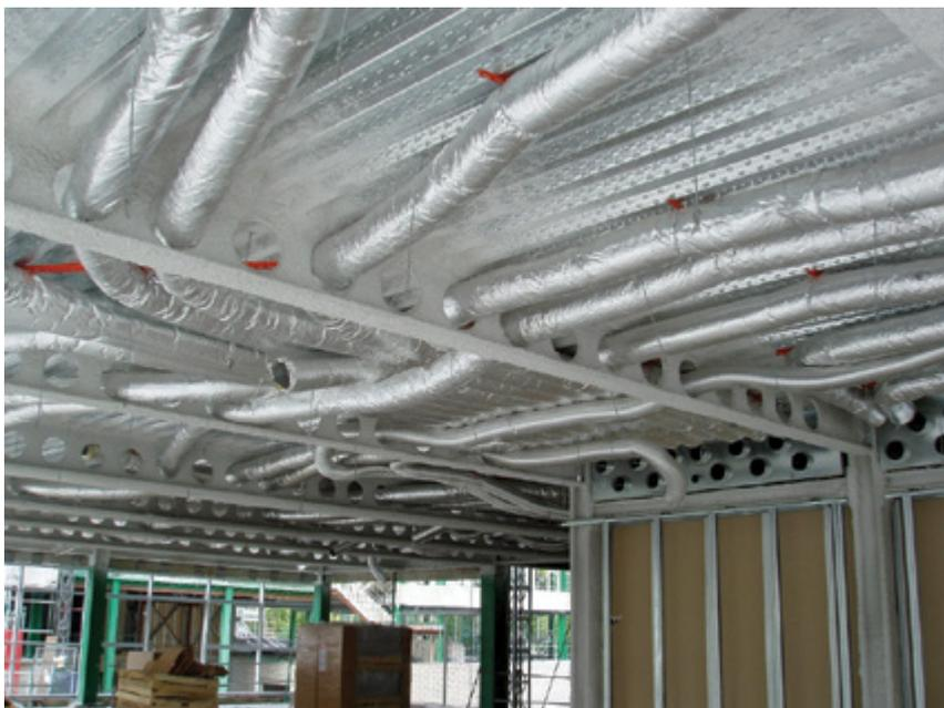
Рисунок 2. Размещение трубопровода инженерных систем в объеме перекрытия.
