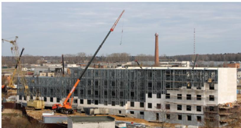
Каркас – из стальных холодногнутых оцинкованных профилей по ТУ 1122-001-82866678-2011 из стали 350 по ГОСТ Р 52246-2004 с цинковым покрытием 1-й категории (275 г/кв. м).
